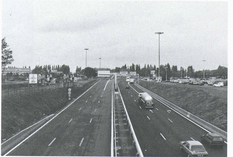
Fig. 5. – La traversée TGV de Lille a nécessité la déviation du périphérique et le commencement des travaux par l'entonnement sud.
