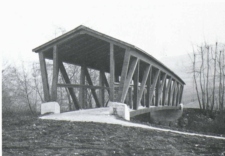
Passerelle couverte sur l'Engelbergeraai, Buochs (NW). Portée: 24 m; Largeur: 3 m; masse 7,5 t. Ingénieur: Hans-Heini Gasser, Lungern (OW).
