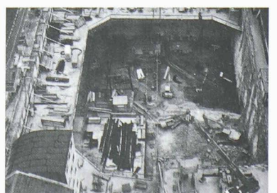
Fig. 9. – Bétonnage de l'anneau de compression, 2 ème étape, août 1991
