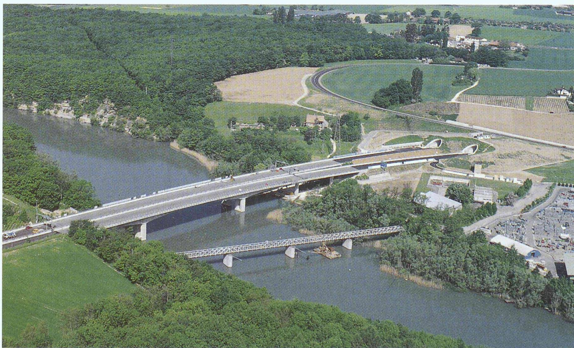
Pont d'Aigues-Vertes: vue aérienne
