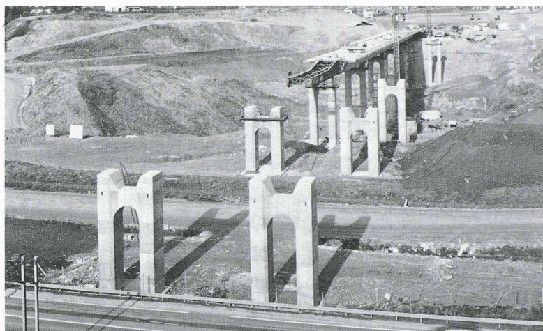
Fig. 3. – Viaduc de Bardonnex en construction
