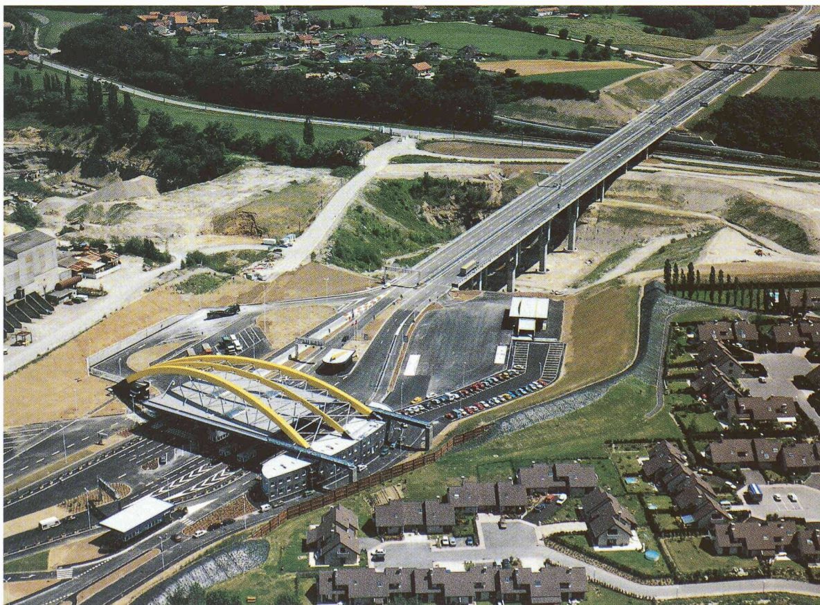
Fig. 5. - Plate-forme douanière française et viaduc de Bardonnex
