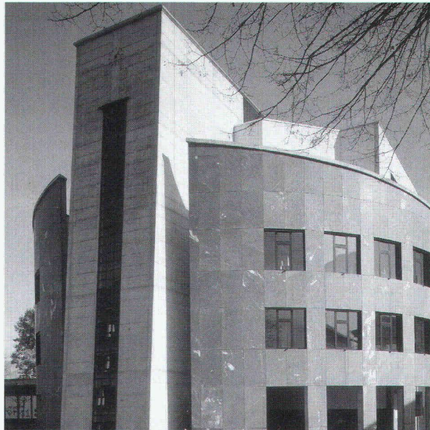
Bâtiment scolaire, Martigny
