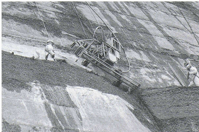
Fig. 5. – Robot d'hydrodémolition. La tringle de guidage de la lance est bien visible.
