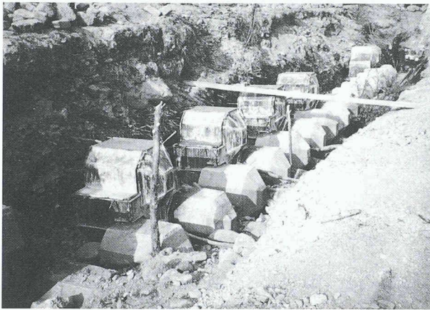
Fig. 11. – Coffrages métalliques et blocs terminés
