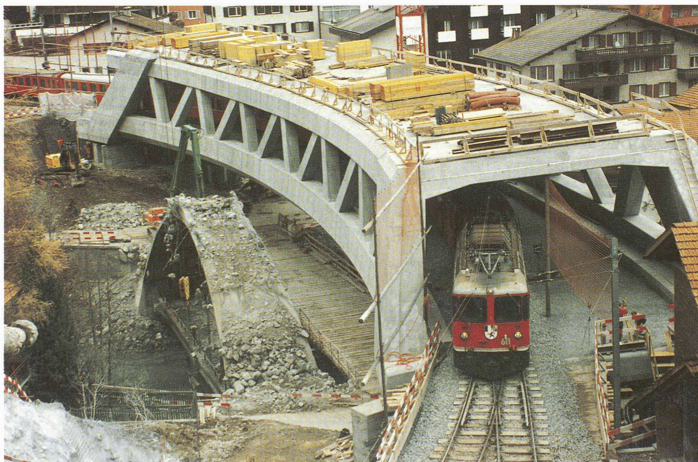
Fig. 15. – Encore à son emplacement provisoire, le nouveau pont est déjà en service, alors que l'ancien est en démolition
