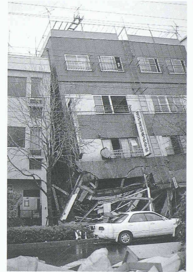
Fig. 18. – Ancien bâtiment endommagé, incliné contre un bâtiment récent intact
