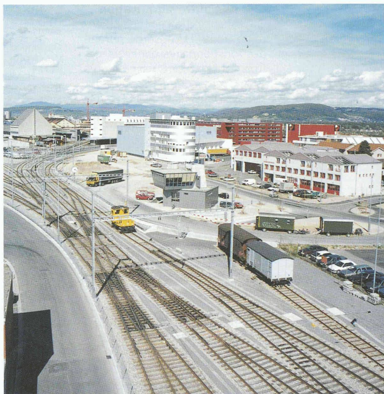
Le cœur du nouveau complexe: le faisceau de voies et la station de service «Bâle Dreispitz»
