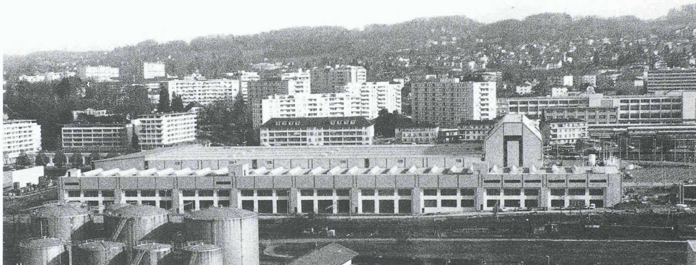
Fig. 5. – Nouveau centre d'exploitation de Perrelet des TL: vue depuis le sud
