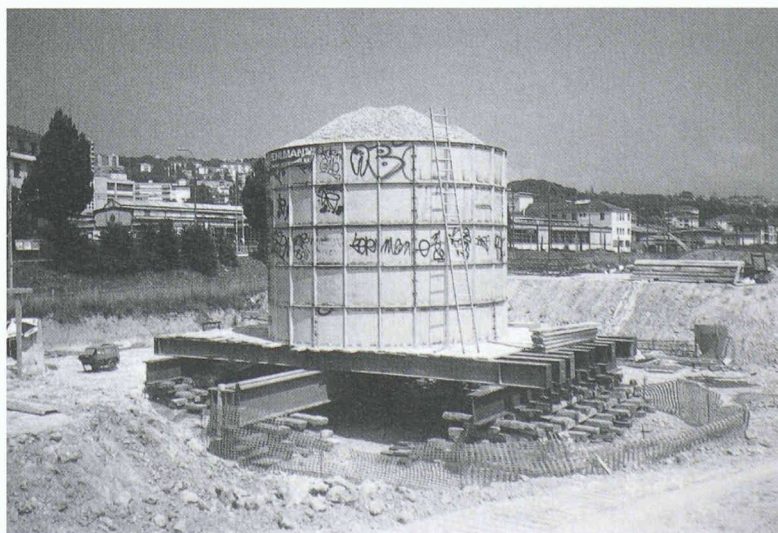
Fig. 4. – Essai de charge des pieux sous un poids de 300 t
