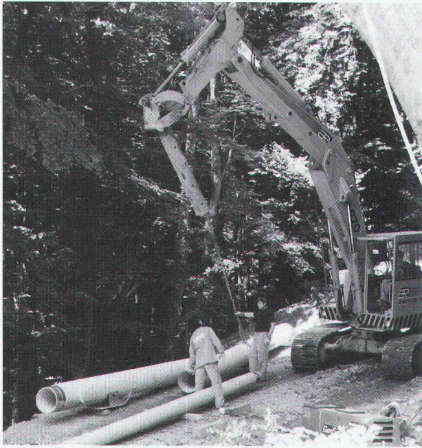
SI de la Ville de Fribourg + Frigaz SA: Aqueduc et gazoduc sous le Pont de Pérolles
