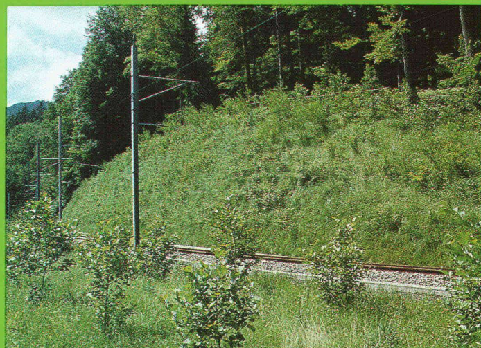
CH-Sihlwald, 1987; H = 10,0 m, L = 95 m; Ouvrage de revêtement
