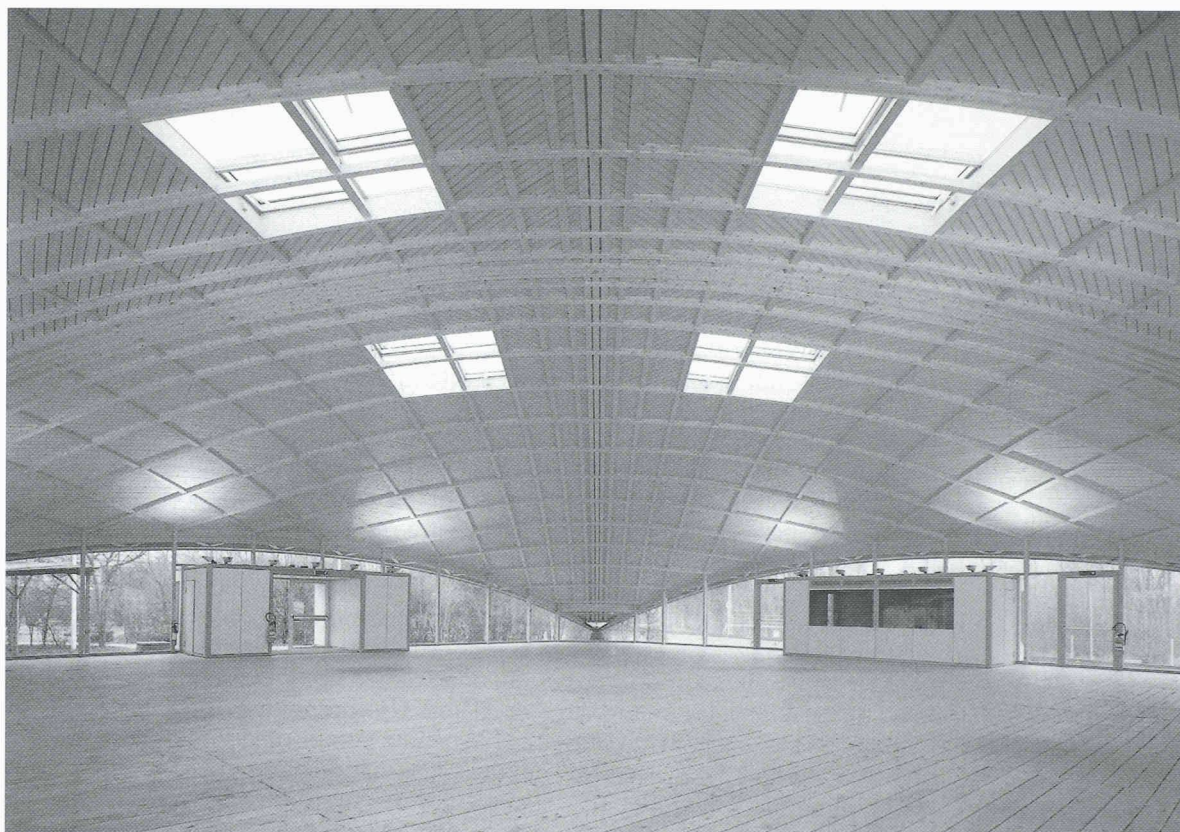
Fig. 1. – Polydôme de l'EPFL, réalisé à l'occasion du 700 e anniversaire de la Confédération et destiné, à l'époque, à recevoir l'exposition «Miroir des techniques». Il est basé sur le système statique d'une grille de planches cintrées. L'épaisseur de chaque nervure contient seulement quatre planches de 27 mm vissées. (Architectes: D. Badic et associés, Morges; ingénieurs: J. Natterer et Bois Consult Natterer, Etoy) (Photo H. Germond)
