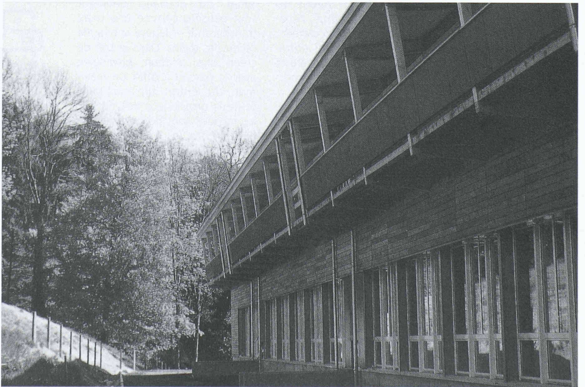
Vue façade est
