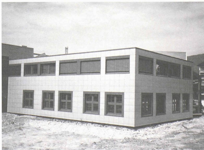
Fig. 1.- Le bâtiment étudié (bâtiment administratif de Schäublín à Delémont)
