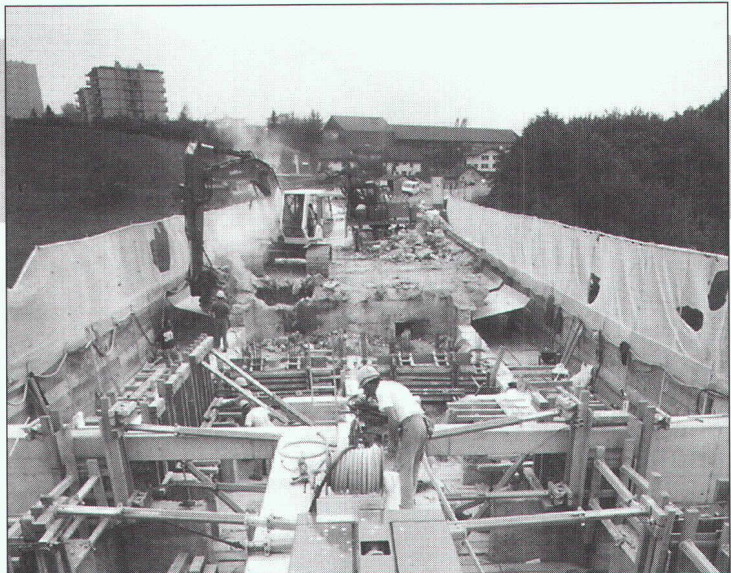
Rénovation et élargissement du Pont de Pérolles, Fribourg, pilotage consortium
