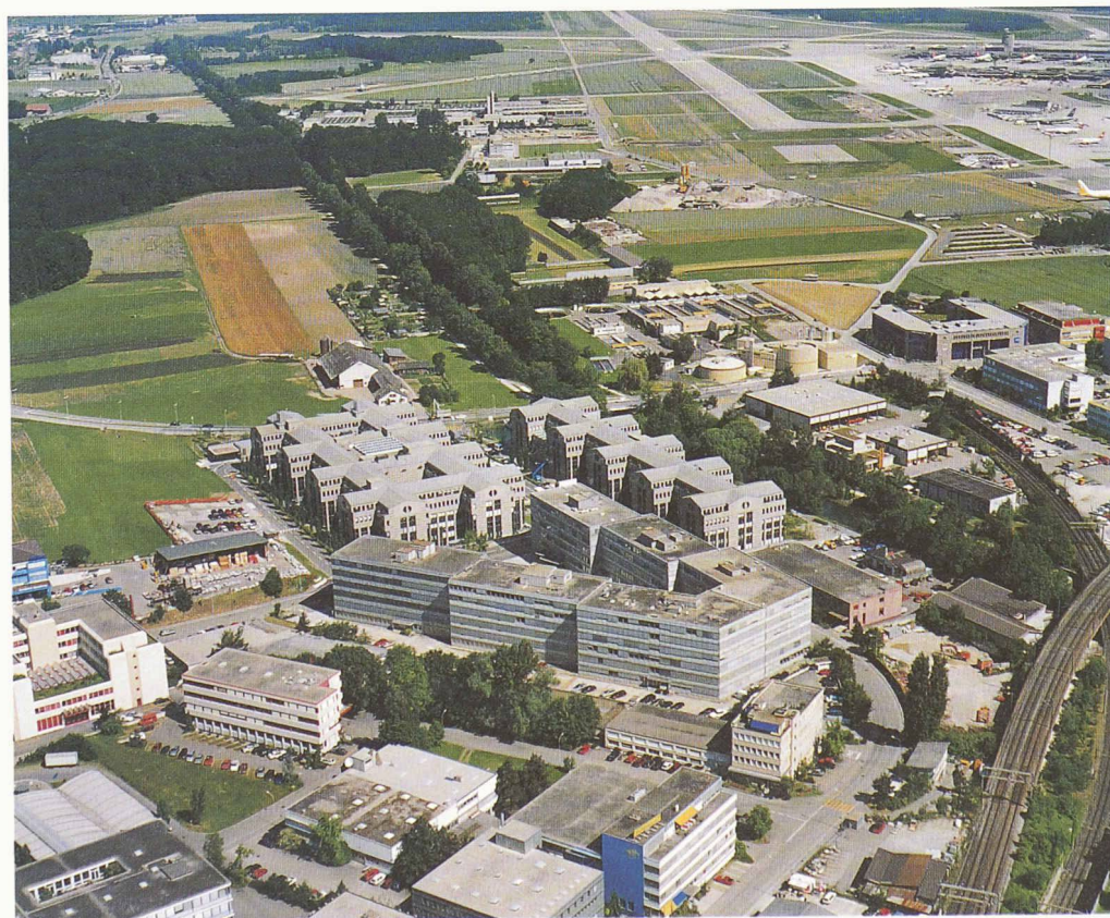
Fig. 8. – Un monde du travail diversifié s'est installé à Glattbrugg-Ouest. La structure construite est hétérogène et l'espace urbain inhospitalier. Dans les deux seuls bâtiments de la Société de Banque Suisse travaillent plus de 1500 employés.
