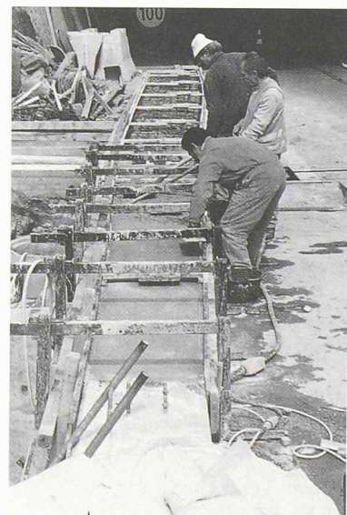
Fig. 5. - Mise en œuvre du mortier
