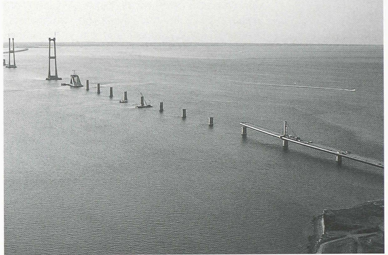
Fig. 6. - Pont de l'Est en construction
