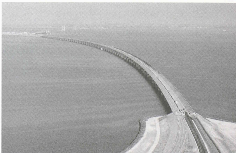
Fig. 3. - Pont de l'Ouest: ouvrage à trafic mixte sur 6,6 km (Photo: A/S Storebaeltforbindelsen)
