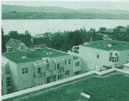
Toit plat rendu aménageable: végétalisation extensive Sarnavert sur du Sarnafil T.
