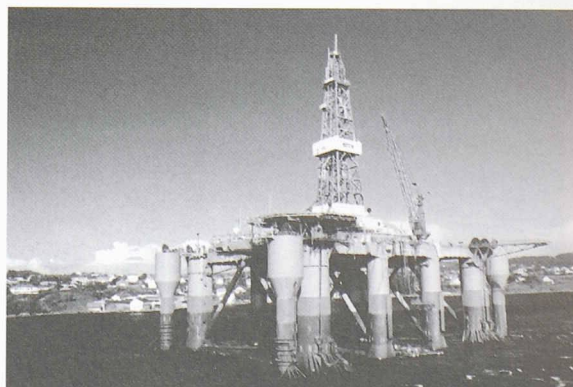
Plate-forme pétrolière en construction
