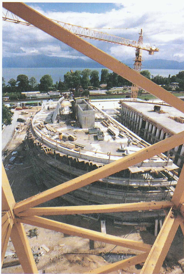
Vue partielle du chantier
