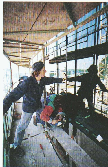
Pose des façades vitrées; pas moins de septante corps de métier ont été appelés à collaborer.
