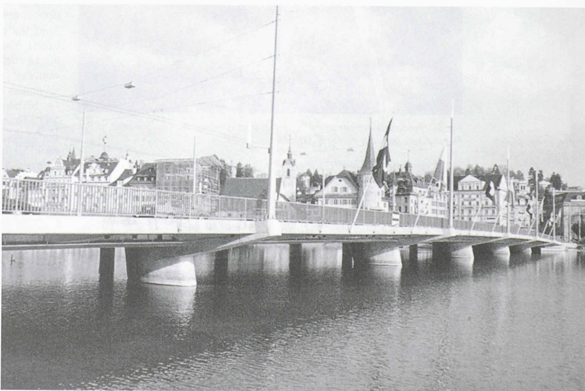
Fig. 8. - Vue du nouveau Seerücke
