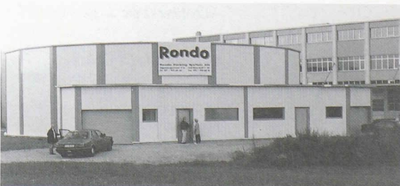
Expériences novatrices sur le chantier du parking d'Oberbüren: une construction ronde et, à la place du béton armé, un squelette en acier pour les futurs box où emmagasiner les véhicules
