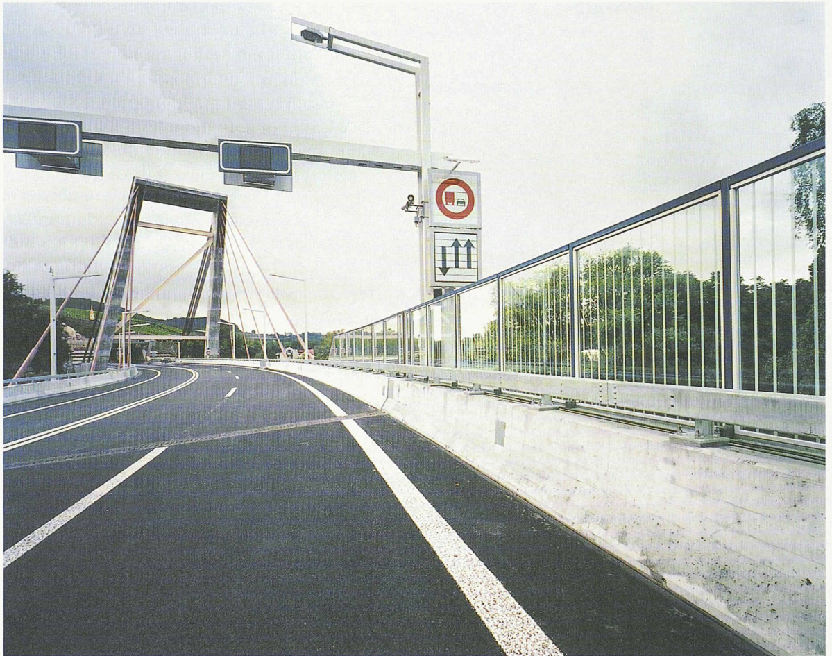
Fig. 3. – Le nouveau pont autoroutier de Schaffhouse: vue partielle de l'ouvrage équipé (photo: Rolf Wessendorf).
