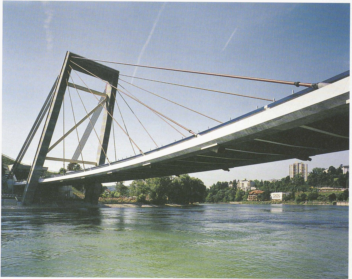
Fig. 2. – Le nouveau pont autoroutier de Schaffhouse: vue partielle avant la finition de l'ouvrage (photo: Rolf Wessendorf).
