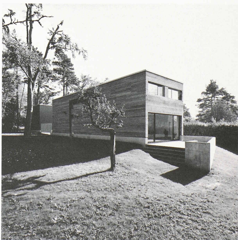
Façade nord, vue sur terrasse-séjour
