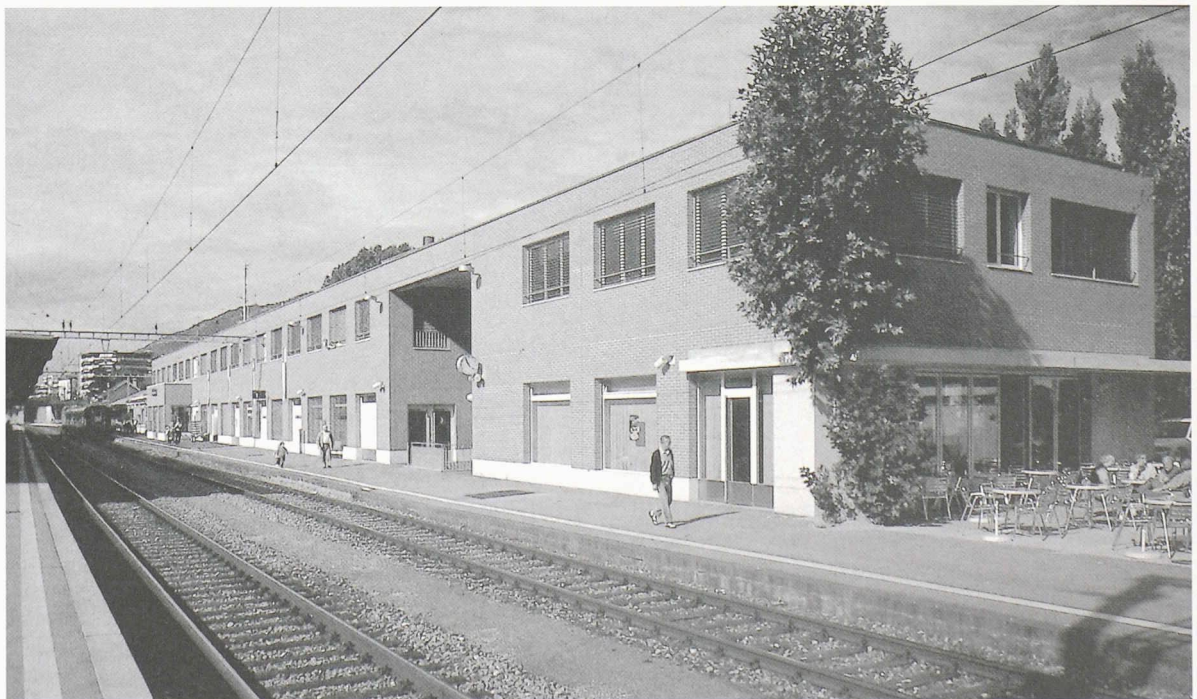
Façade sud (photo atelier d'architecture)
