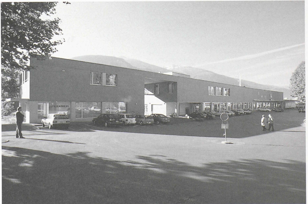
Façade nord et place de la Gare
