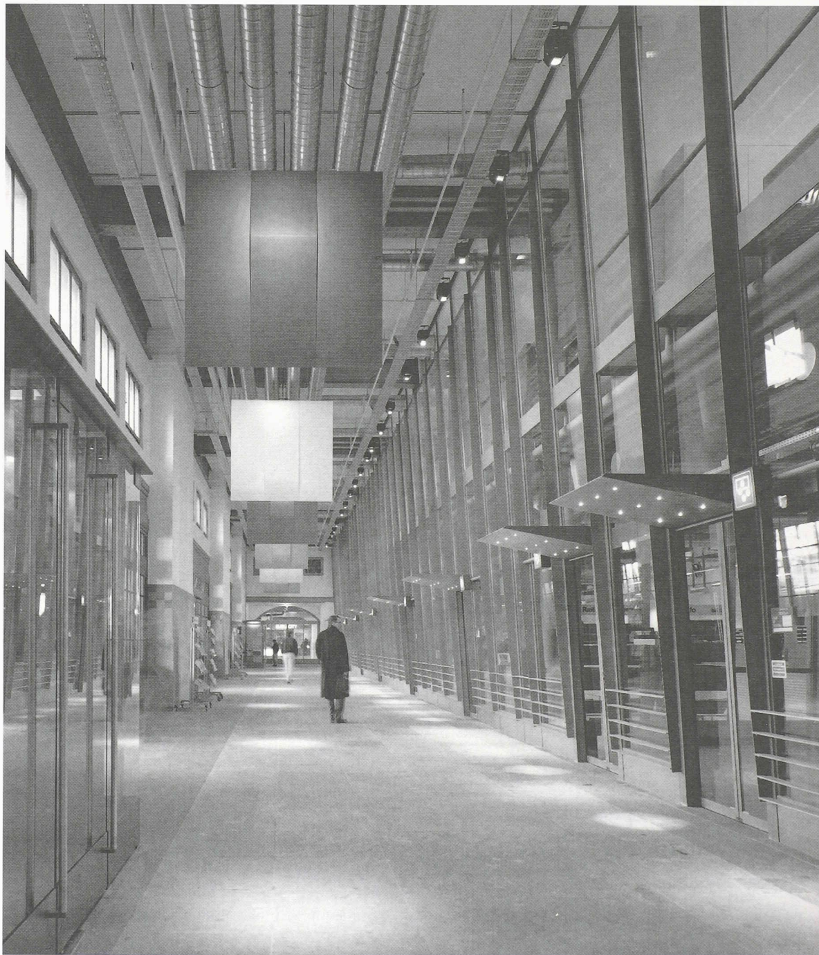
Le hall des pas perdus, filtre entre la place de la Gare et les services ferroviaires. La façade extérieure est minérale, massive et peu percée, la nouvelle façade intérieure est métallique, légère et transparente
