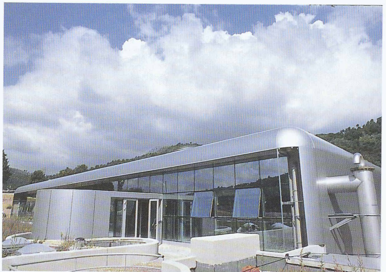
Usine d'ultrafiltration de l'Apié St-Cassien (Côte d'Azur) du Groupe Suez-Lyonnaise des Eaux, d'une capacité actuelle de 25 000 m 3 /jour, utilisant la technique membranaire d'ultrafiltration Aquasource similaire à celle prévue à Lutry
