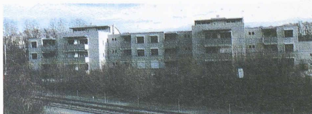
Fig. 1. – Les Triades D (une description du projet et de sa conception architecturale a paru dans IAS 24/1997, pp. 492-495)
