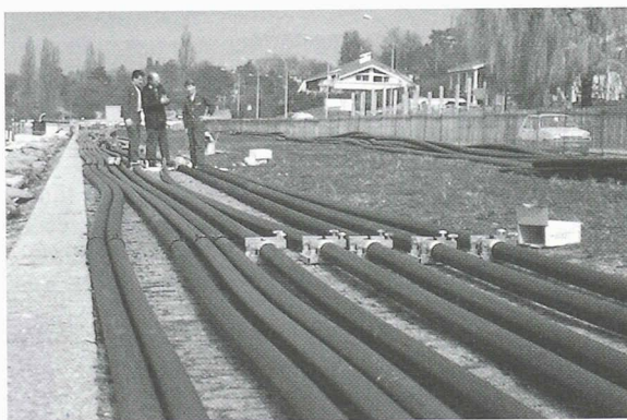
Pose de tubes sur un chantier (Genève)
