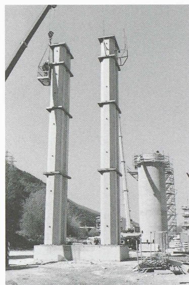
Fig. 9.- Pile provisoire en béton centrifugé
