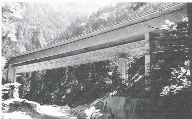
Fig. 1. – Partie sud du pont enjambant la Reuss
