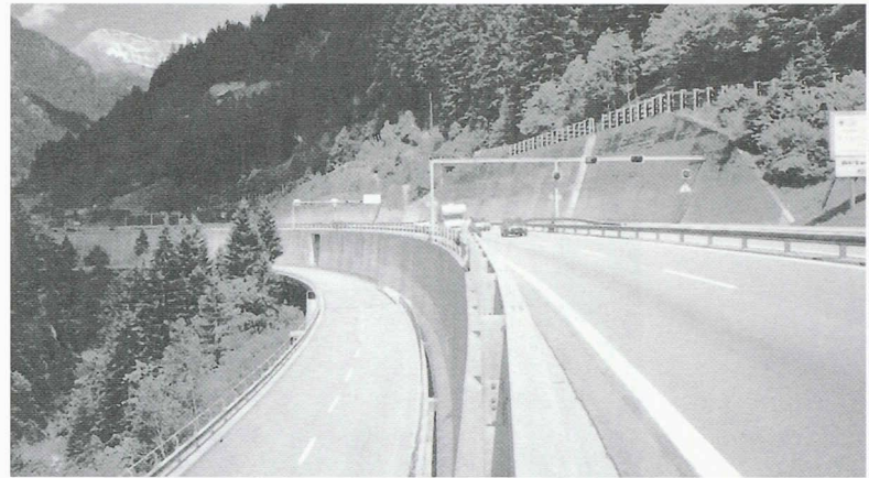
Fig. 13.- Murs et parois de soutènement, vue générale
