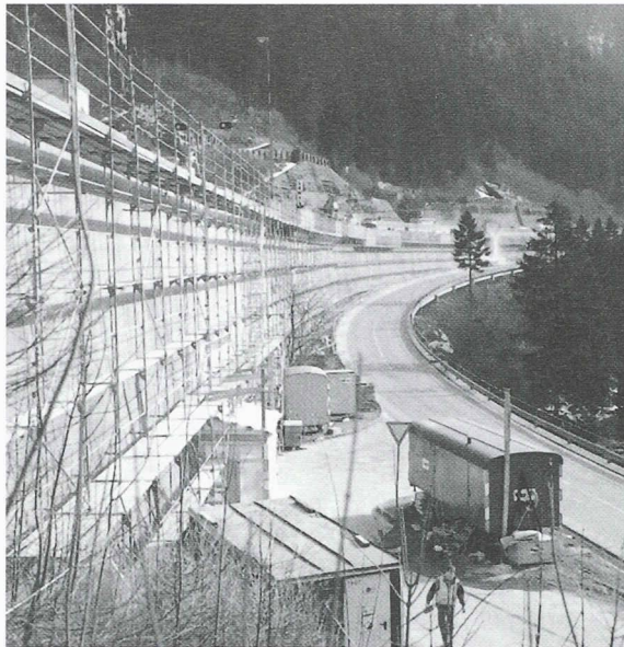
Fig. 16. - Echafaudages d'un mur de soutènement
