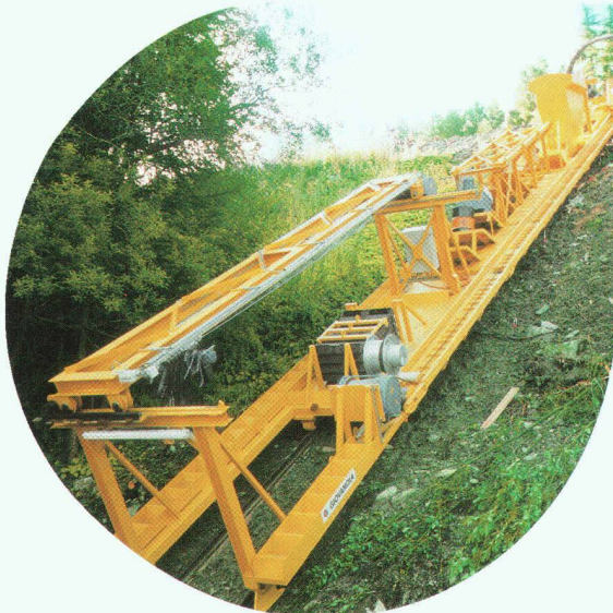
Cleuson-Dixence, Back-up pour tunnelier LOVAT
