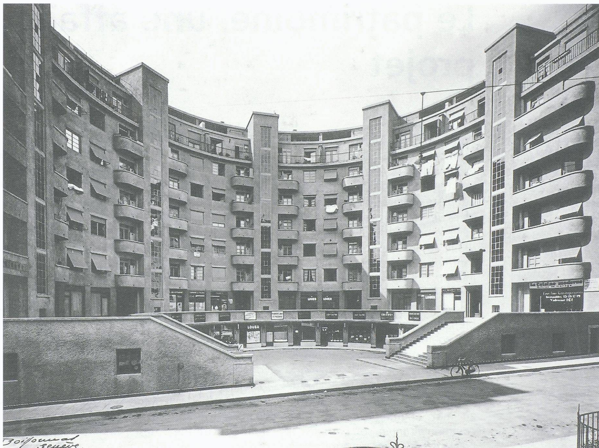
Maison ronde, vue de la cour intérieure. (Photo Berthet d'après Boissonas © Fondation Braillard, Genève. Cote 04.142.1)
