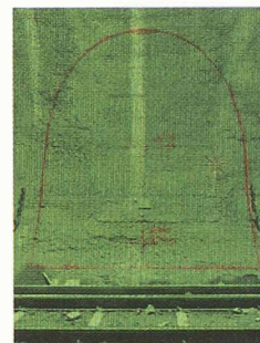
Profil de percement transversal, tunnel de base du Gothard (Photo Milo Keller, ECAL)
