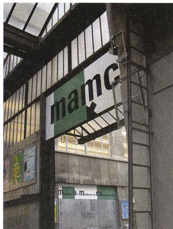
Transformation d'une friche industrielle (SIP à Genève) en musée d'art contemporain: le MAMCO (Photographie M. Jaques)
