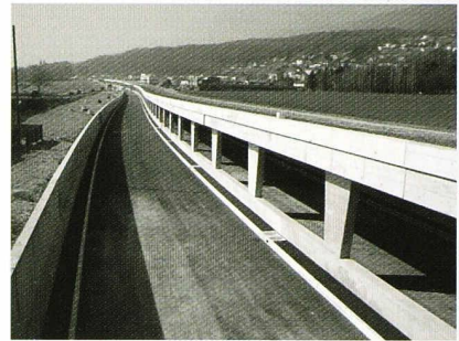
Tranchée semi-couverte de Bevaix (Photo Groupe d'ingénieurs Associés-GIA)
