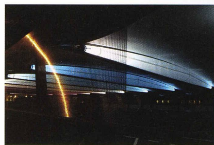
La structure Tensairity ® du parking de la gare de Montreux (Photo Luscher Architectes SA)
