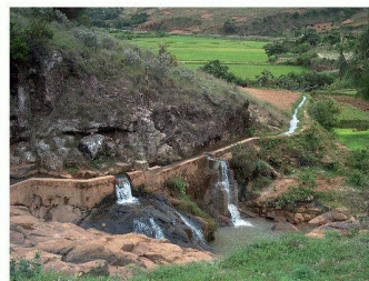
Site d'implantation pour une pico-centrale (Photo AZ Ingénierie)
