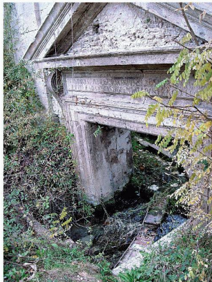
La porte d'entrée de la Chiesa San Vittorino (Photo Eugène)
