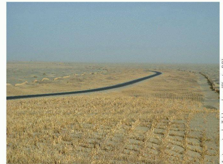
Autoroute du Taklamakan (Photo DR)
