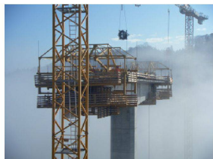
Construction des viaducs du Creugenat. (Photo GVH)
