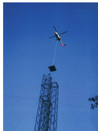
Montage d'un pylône (Photo Paul Glassey SA)
