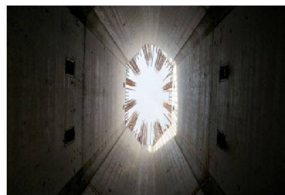
Intérieur d'une pile du pont de la Poya (Photo Etat de Fribourg / Eric Sautere)
