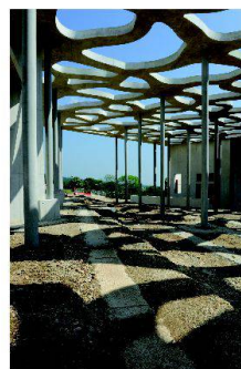
Partie nord de la canopée (Photo Leo Fabrizio)
